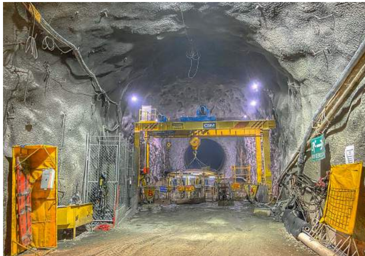
El lleno de la oquedad logra darle mayor seguridad a la estabilidad del macizo, informó el gerente Álvaro Rendón. FOTO CORTESÍA
